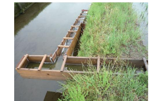
↑大きな排水路からは木製の階段式水路を作り、魚が遡上しやすい構造にしています。
