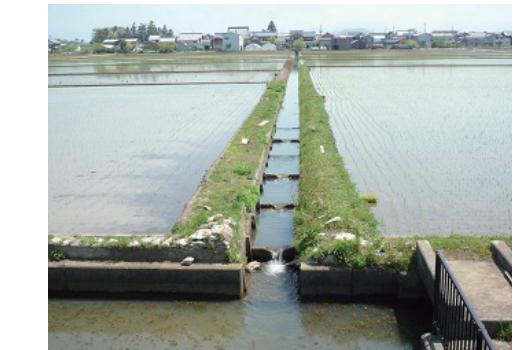
↑排水路を木製の堰板で堰上げて水面を高くし、田んぼに魚が入りやすい構造にしています。
